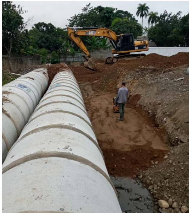
Contruccion Drenaje Pluvial y Mejoramiento Cañada
